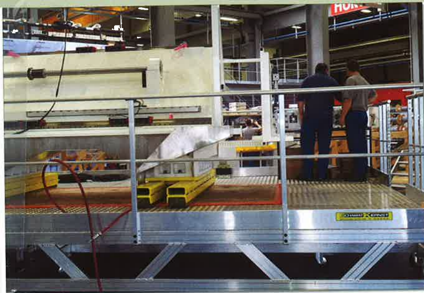
Montage d'un portique de machine au sein du nouveau hall.
